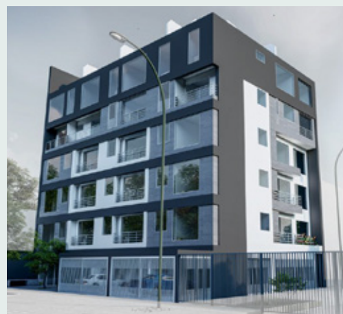
EDIFICIO SAN EUGENIO (2023)
